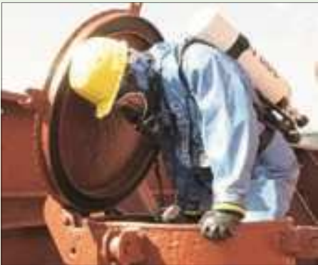
Esempi di lavori in luoghi confinati
