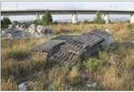
Situazione non regolare, materiale con possibile contenuto di amianto abbandonato sul terreno
