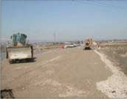
Esempio di mezzi d'opera semoventi in cantiere
